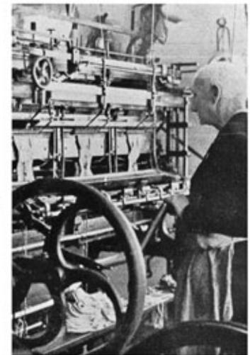
Mit der Cottonmaschine begann ein neues Zeitalter für die Wirkerei. Mit ihr wuchs die Produktion. Da aber diese Maschine 5 oder noch mehr Fonturen besaß, waren größere Räume notwendig. Eine *Fontur* ist ein Maschinenteil für einen Strumpf. Also wurden bei einem Arbeitsgang 5 oder mehr Strümpfe hergestellt.
