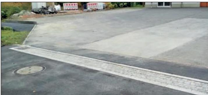
Die desolate Entwässerungsrinne zur Zufahrt zum Feuerwehrgerätehaus wurde durch eine Pflasterrinne ersetzt. Kostenumfang 12.559,00 Euro. Baubetrieb war Phönix Bau GmbH aus Aue.
